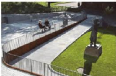
新建无障碍坡道
