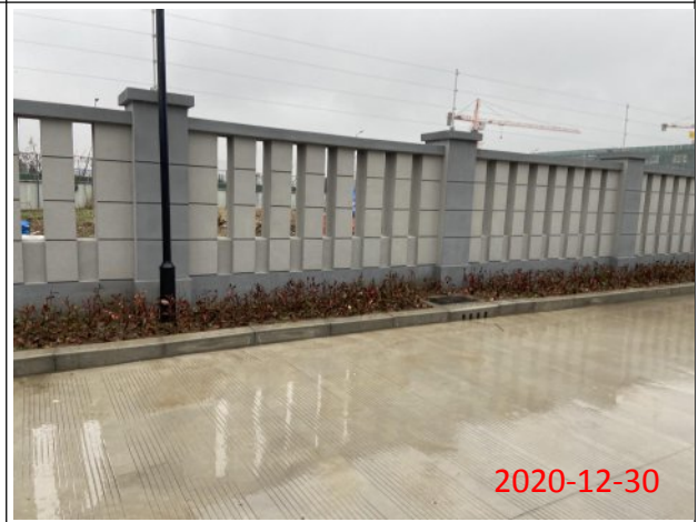
绿化（泵站及管网工程区）
