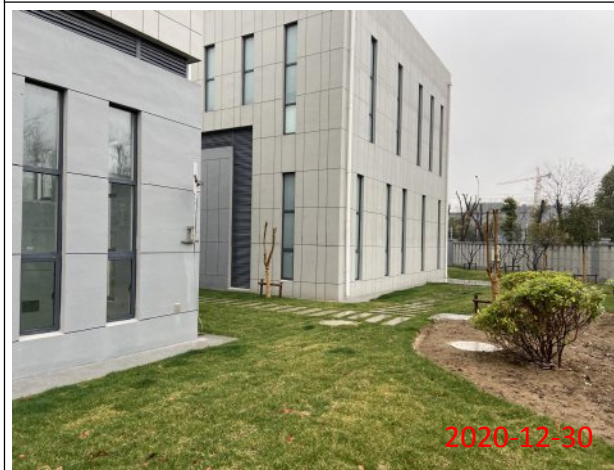
绿化（泵站及管网工程区）
