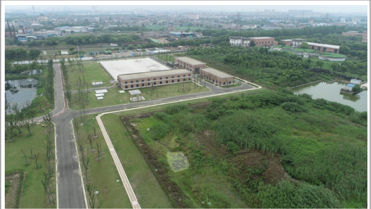
污水处理厂区-临时堆土区
