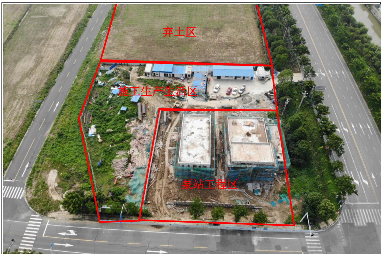
图 1.1 泵站及管网工程区施工进度
