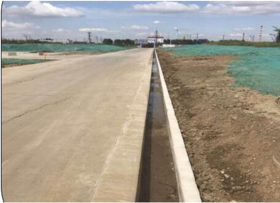
施工便道区临时排水沟
