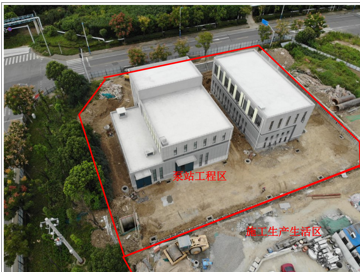
图 1.1 泵站及管网工程区施工进度
