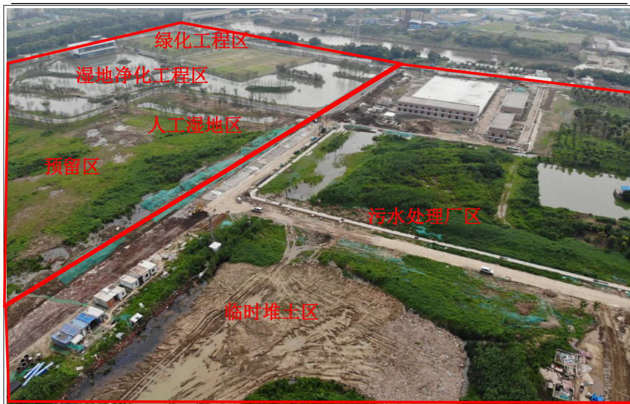
图 1.2 污水处理厂区、人工湿地区施工进度
