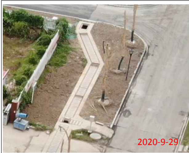
雨水管网（污水处理厂区）
