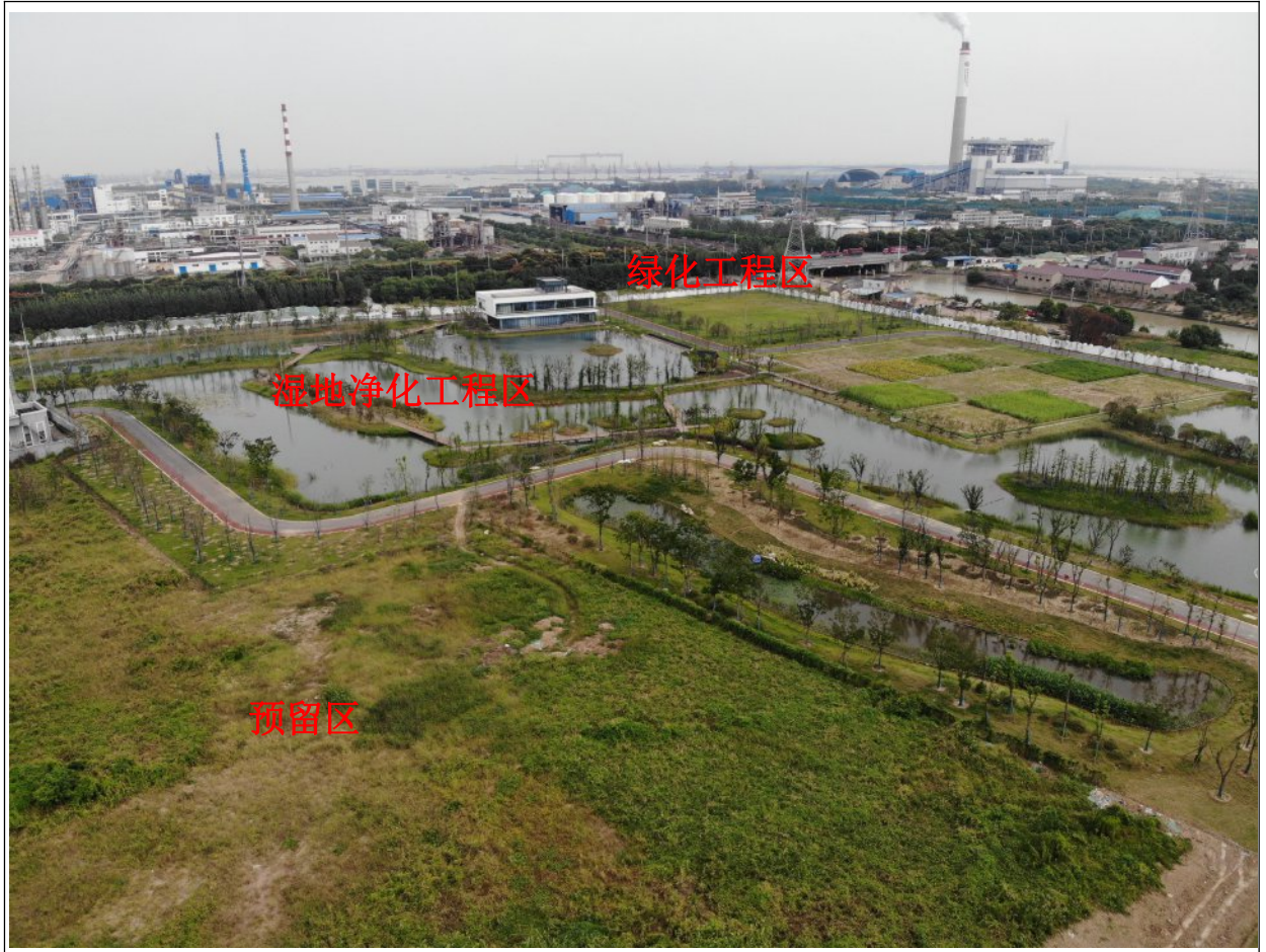
图 1.2 人工湿地地区施工进度
